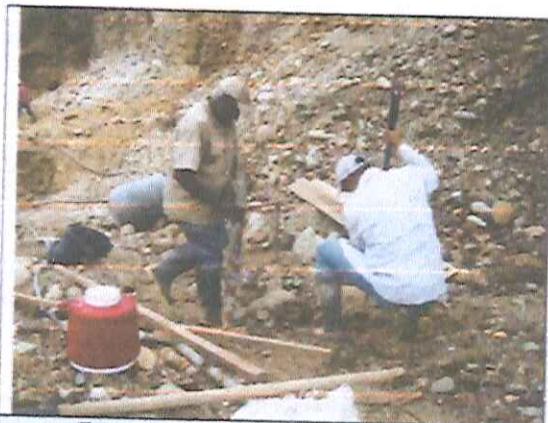
Foto 1. Construcción sitio de lavado
