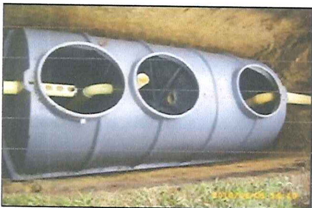
FOTOGRAFIA 3. Tanque séptico instalado.
