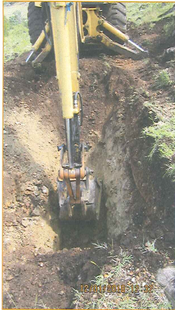
FOTOGRAFÍA 2. Detalle del avance del Sondeo, Trch – 02, exploración preliminar de litologías.
