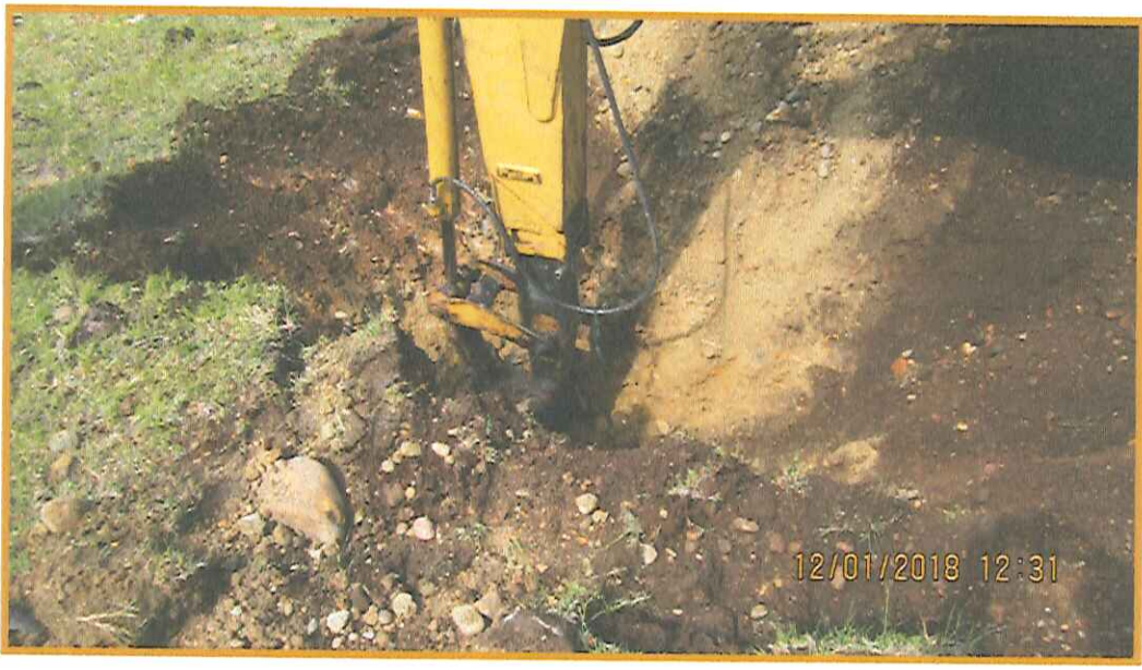
FOTOGRAFÍA 1 Detalle inicio del Sondeo, Trch – 02, exploración preliminar de litologías.
