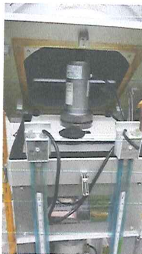
Fotografía 2 Calibración PM10 Estación Escuela
