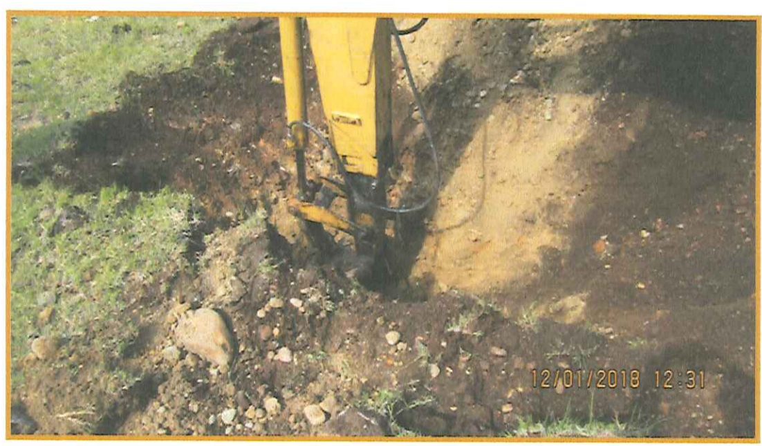
FOTOGRAFÍA 2 Detalle inicio del Sondeo, Trch – 02, exploración preliminar de litologías.
