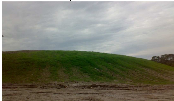
Foto 2 Empradización de taludes
