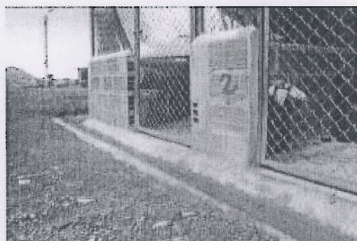
bbCunetas perimetrales en caseta de combustibles
