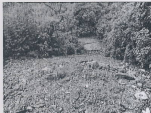
Método de contención de los estériles y su manejo en el sitio, se evidencia pocas condiciones de estabilidad y aun más en cercanías a la vía de acceso a la mina
