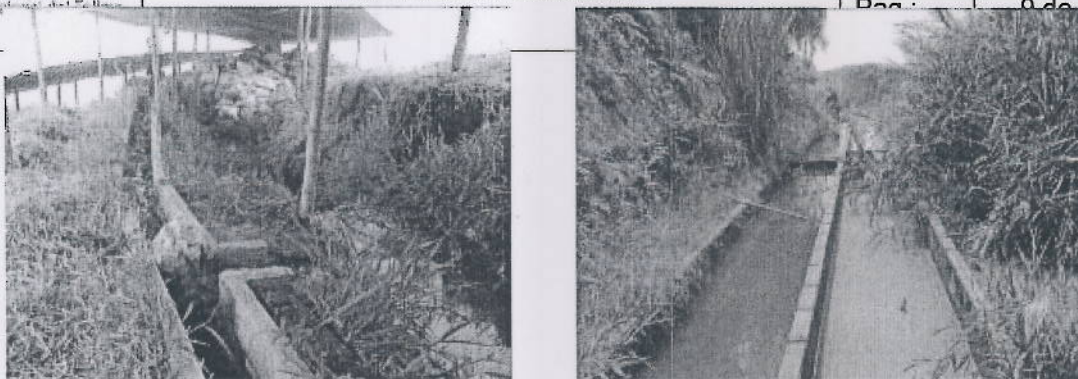
Canales para favorecer la sedimentación de las colas de cianuración
