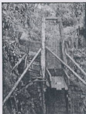
Método de contención de los estériles y su manejo en el sitio, se evidencia pocas condiciones de estabilidad y aun más en cercanías a la vía de acceso a la mina
