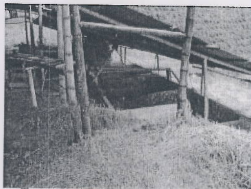
Tanques de cianuración y tanque de precipitación de valores
