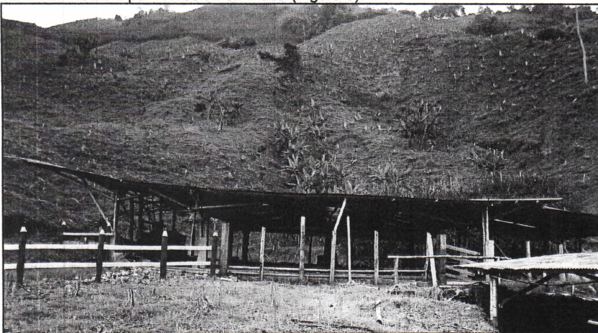
Figura 9. Vista general del sitio del proyecto y alrededores, en donde se aprecia la ausencia de procesos de inestabilidad.
