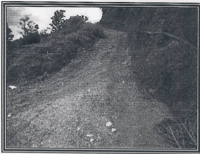
Fotografía 2. Vía a El Convenio, en mantenimiento con material estéril proveniente de la mina.
