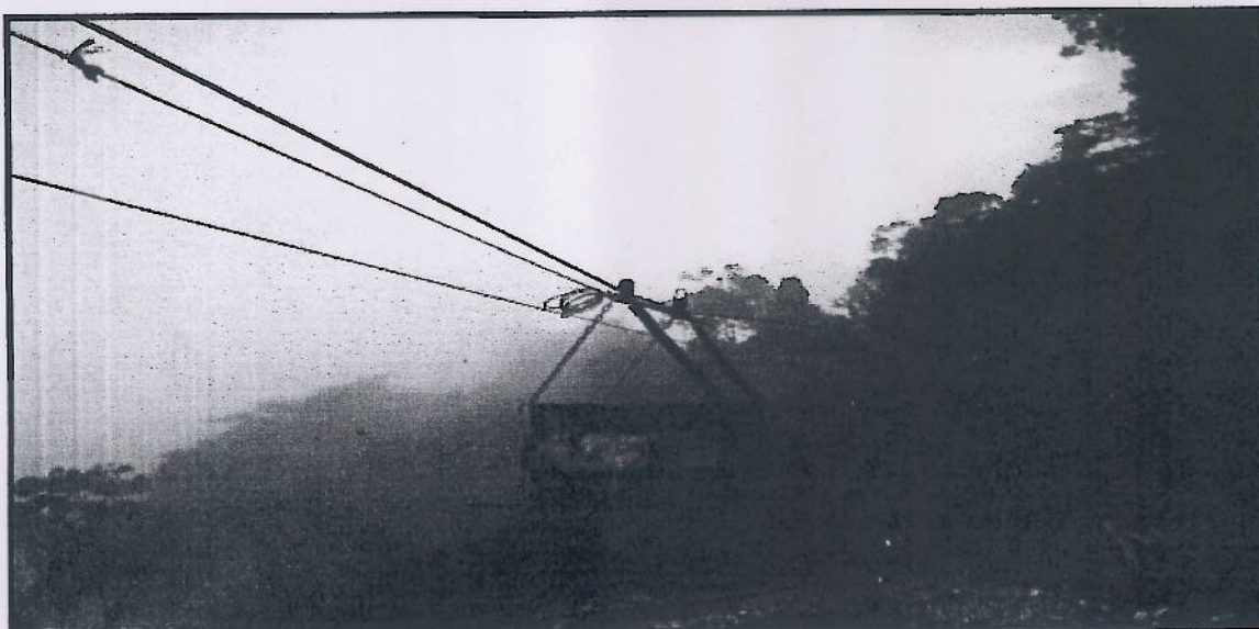
Fotografía n.º 9: Cable aéreo para el transporte externo del material extraído.
