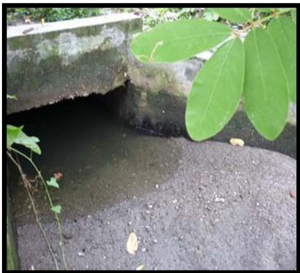
Foto 2. Zona de ingreso aguas lluvias Humedal Laguna La Herreruna
