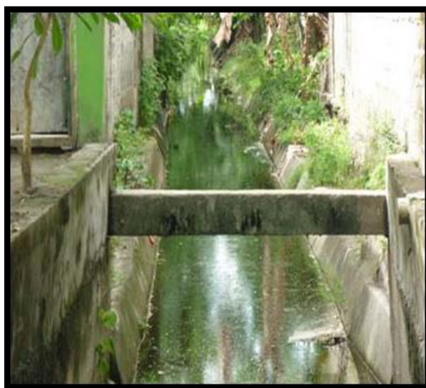
Foto 3. Canal de drenaje Humedal Laguna La Herreruna
