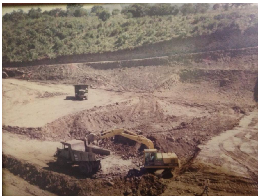
Figura 5.2. Construcción de la laguna El Toro
