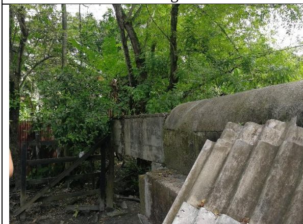
Obra hidráulica en dirección al predio
