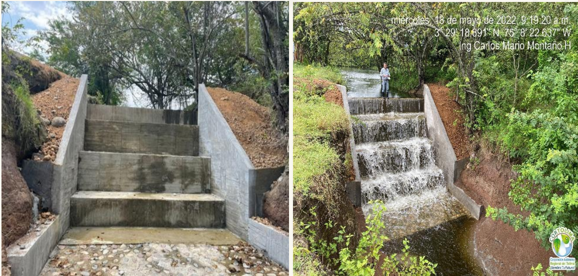
Imagen 23. Registro Fotográfico de la Estructura de Salida del Reservorio de Agua en la Vereda Yaco Molana del Municipio de Natagaima
