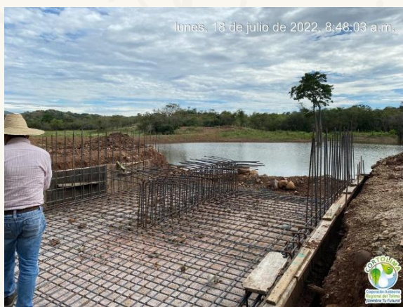
Imagen 20. Registro Fotográfico de la Estructura de Salida del Reservoirio de Agua en la Vereda Nataroco del Municipio de Natagaima
