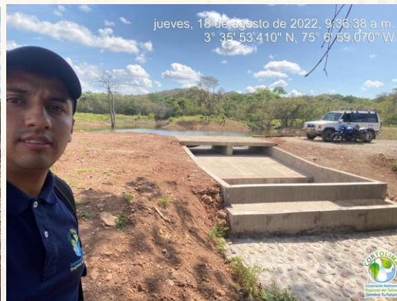
Imagen 20. Registro Fotográfico de la Estructura de Salida del Reservoirio de Agua en la Vereda Nataroco del Municipio de Natagaima
