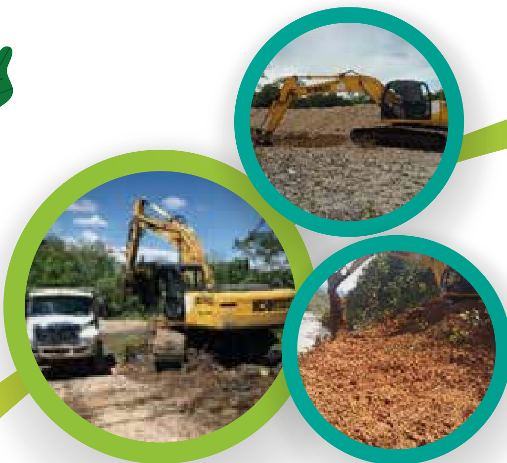
Intervenciones Maquinaria Cortolima - 2020
