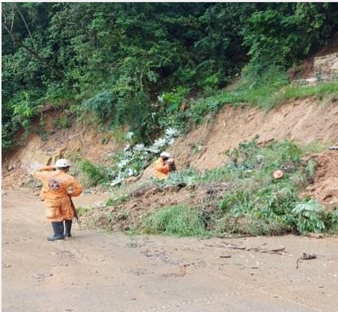
Figura 7. Deslizamiento zona rural municipio de guamo FUENTE. PMGRD 2019
