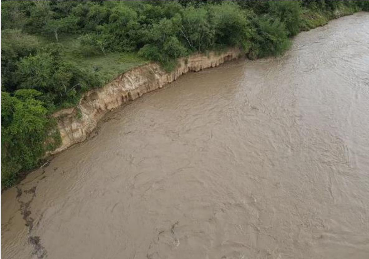
Figura 7: Socavación Chipuelo Oriente Zona Rural Fuente: PMGRD 2021
