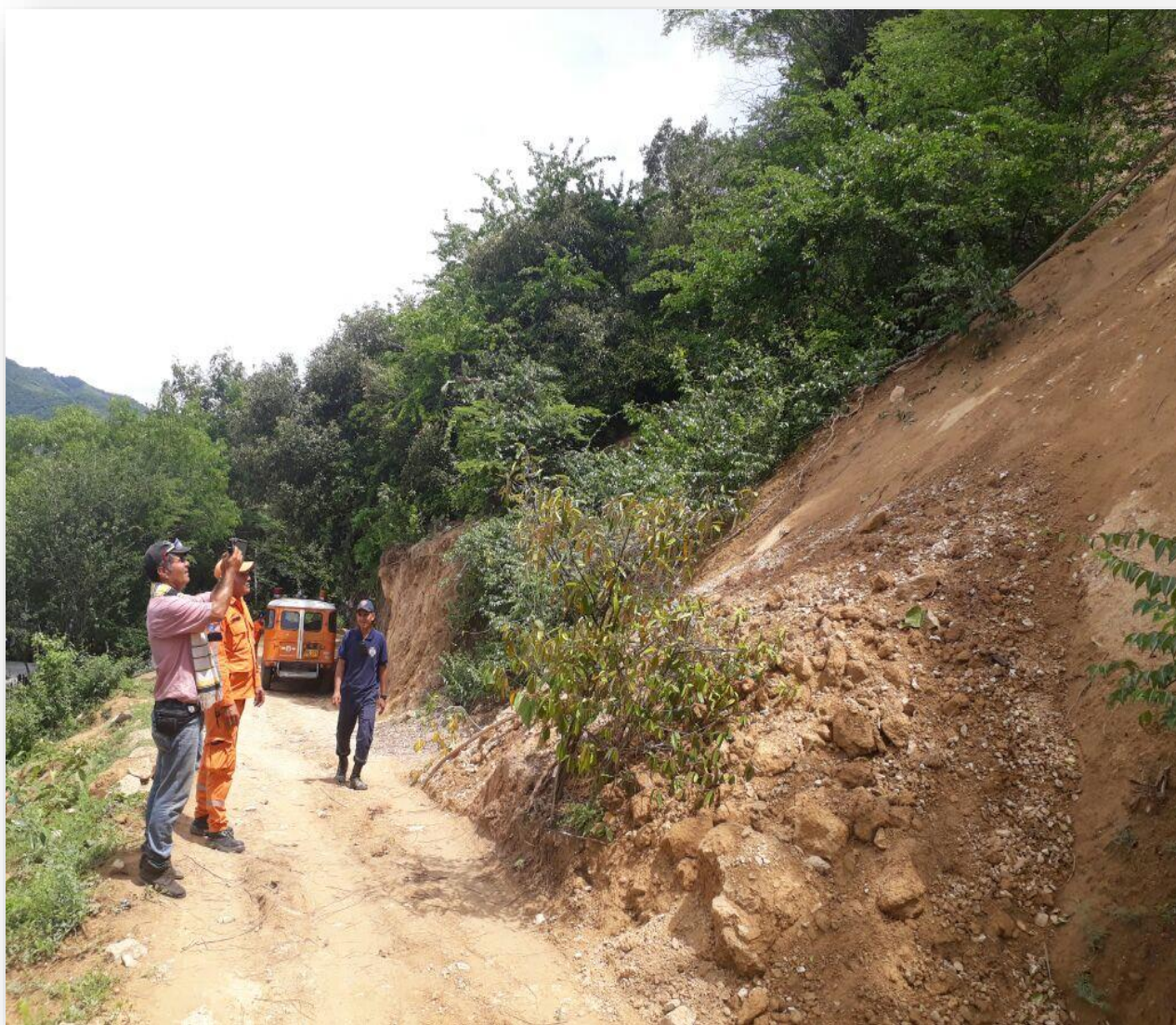
Figura 11. Movimiento en Masa en la Mona Llamada Cerro el Fraile Fuente. CMGRD 2021
