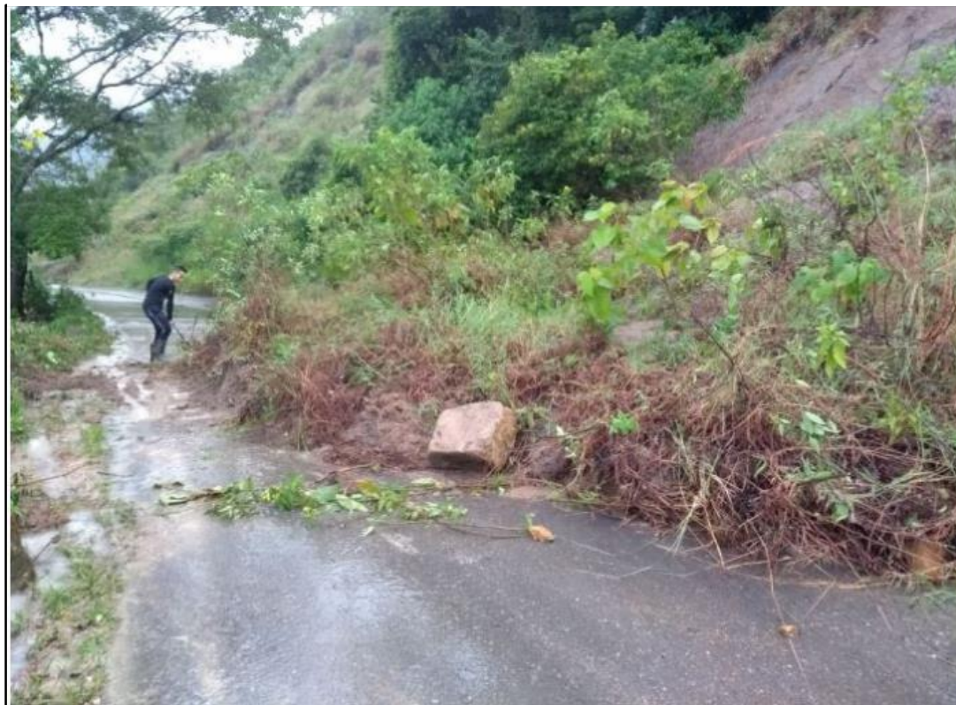
FIGURA 1 AFECTACIÓN POR MOVIMIENTO EN MASA
